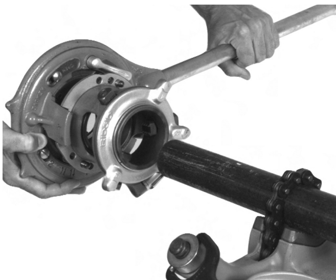
Figure 5 – Enfilage de la fileteuse sur le tuyau
